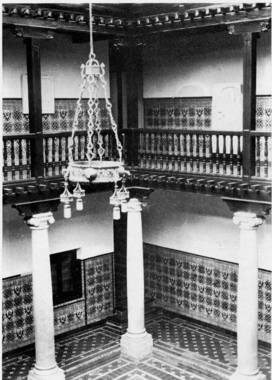
Claustro del Pabellón de Talleres. 1925.
