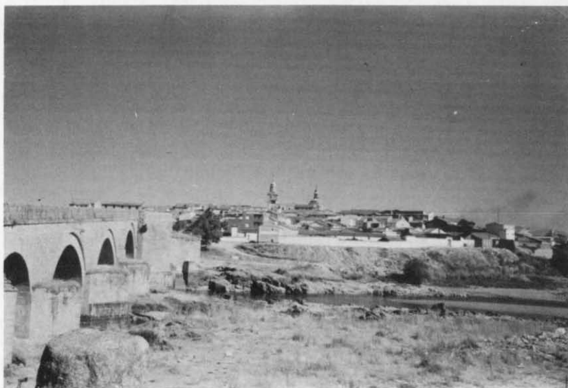
Ponte del Arzobispo. A la izquierda el puente mandado construir por D. Pedro Tenorio.
